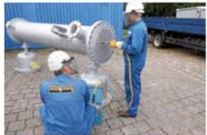
Abb. 11: Einsetzen der Rohrschutzhülsen
