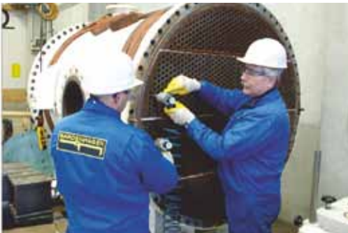
Abb. 1: Techniker bei der Rohrprüfung mit Prüfpistolen
