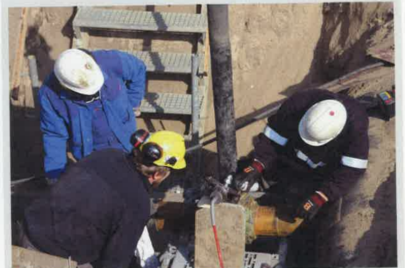
Die Leckabdichtung im laufenden Betrieb wurde vor fast 100 Jahren erfunden und ist in der Prozessindustrie seit Langem ein Standardverfahren. Das Medium Erdgas erfordert allerdings eine besondere Sorgfalt bei der Arbeit. Bild: Bardenhagen
