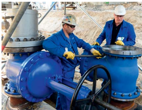
Bardenhagen schlug BASF als kostengünstigere Alternative eine parallele Absperrung von Vor- und Rücklauf mittels Hochdruck-Absperrblasen vor.
