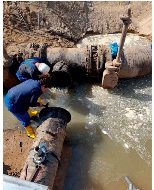
Die Technik der Absperrblasen funktioniert auch im Trinkwasserbereich. Bilder: Bardenhagen
