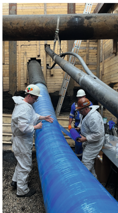
Nach insgesamt zweieinhalb Tagen war die ursprüngliche Wandstärke der Pipeline wiederhergestellt, ohne dass die Versorgung des Stader Werkes unterbrochen war.
