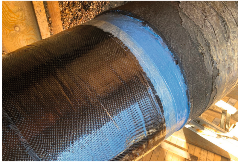
Blick auf den schichtweisen Aufbau: Übergang Karbonfaser, Isolierschicht, Primer und Bitumenverkleidung. Bilder: Bardenhagen
