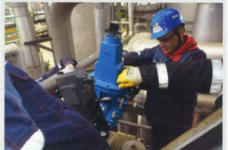
Der Schieberkopf ist installiert und der Eintauchschieber schließt das Rohr sicher ab. Nach rund fünf Monaten Haltezeit der Absperrung wurden die Reparaturmaßnahmen beendet und die Absperrung aufgehoben. Der Eintauchschieber samt Armatur verbleibt für zukünftige Nutzung auf seinem Platz. Bilder: Bardenhagen
