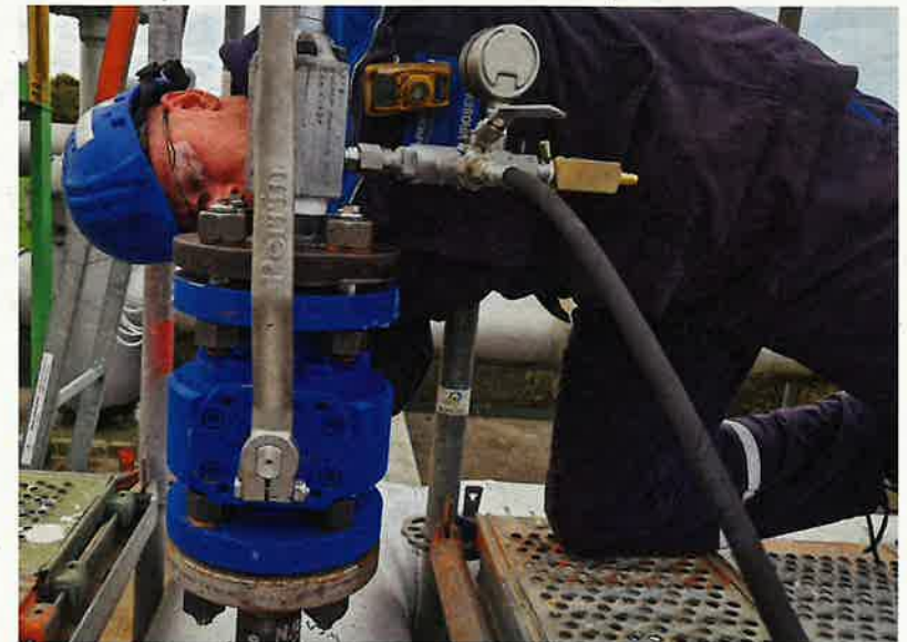
Beim Hot Tapping können medienführende Rohre auch unter Betriebsdruck (bis 100 bar) angebohrt werden: Damit lassen sich Anlagenteile entleeren, nachträglich Armaturen oder Abzweigungen einbauen, Leitungsverläufe ändern oder auch Leitungen im vollen Betrieb entlüften, wenn keine Entlüftungsmöglichkeiten vorhanden sind. Bilder: Bardenhagen
