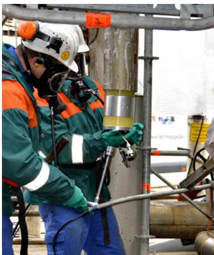
Bild 1: Der DB&B wird in die Leitung eingeführt und die zwei Elastomerdichtungen werden gesetzt
