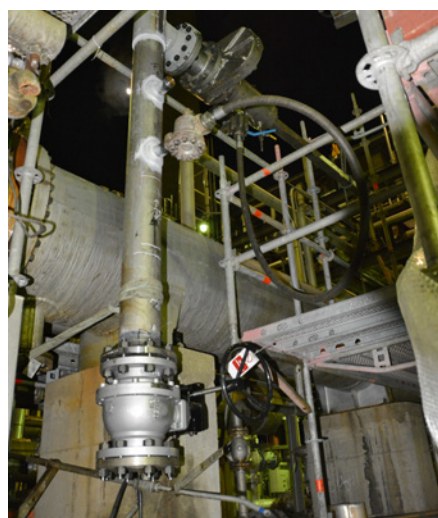
Bild 4: Die fertige Leitung mit dem montierten Kugelhahn
