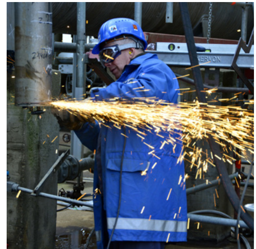
Bild 3: Vorbereitende Arbeiten zum Setzen der Flanschverbindung
