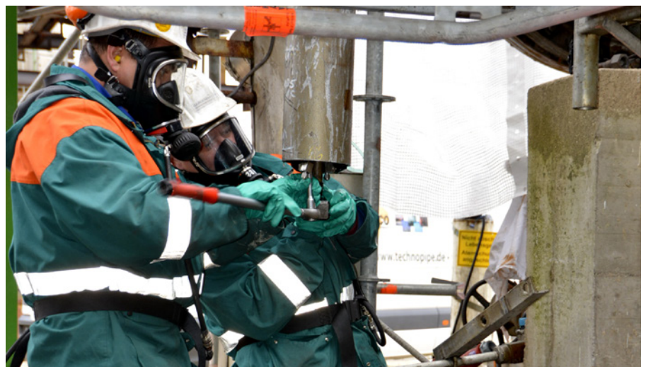
Bild 2: Der feste Sitz des DB&B in der Leitung wird überprüft
